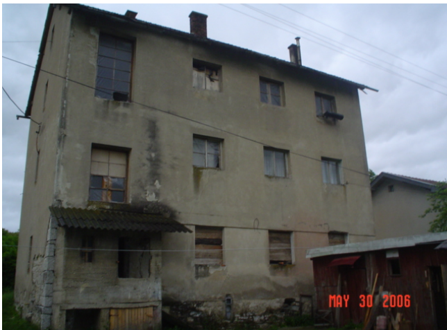
Prije rekonstrukcije i sanacije
