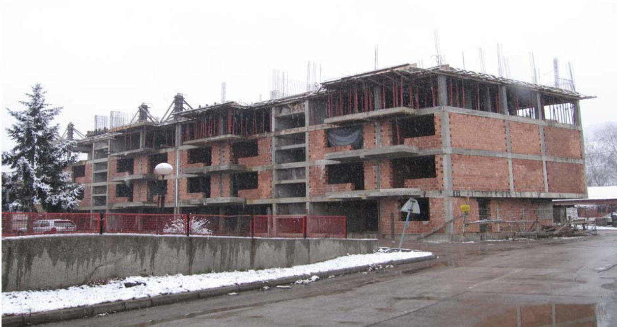
Stambena zgrada u izgradnji - Zenica
